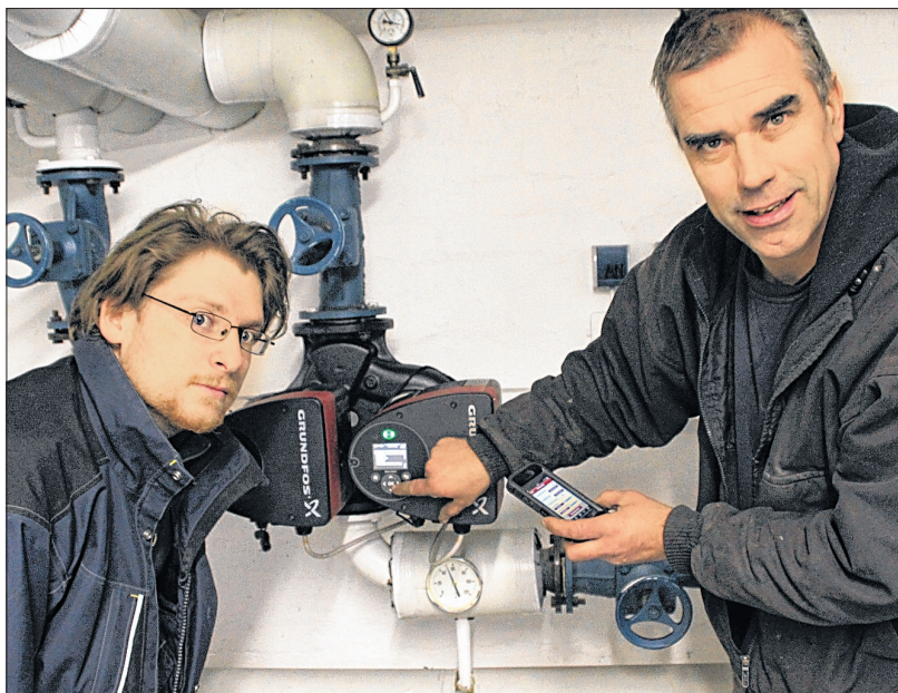
Gerrit Jänitsch und Edward Fellner überprüfen eine intelligente Heizpumpe.
